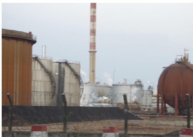
Photo 2 : Vue partielle des cuves de raffinerie de la SIR en zone portuaire de Vridi
