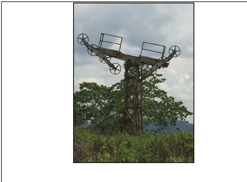
Planche 1 : Pylône (1) et Cuves (2) du téléphérique moandais
