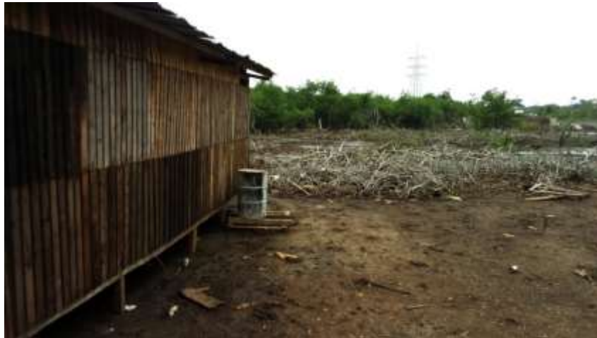
Photo n° 6 : Mangrove dévastée à Alenakiri, près de la Centrale Télémania.
