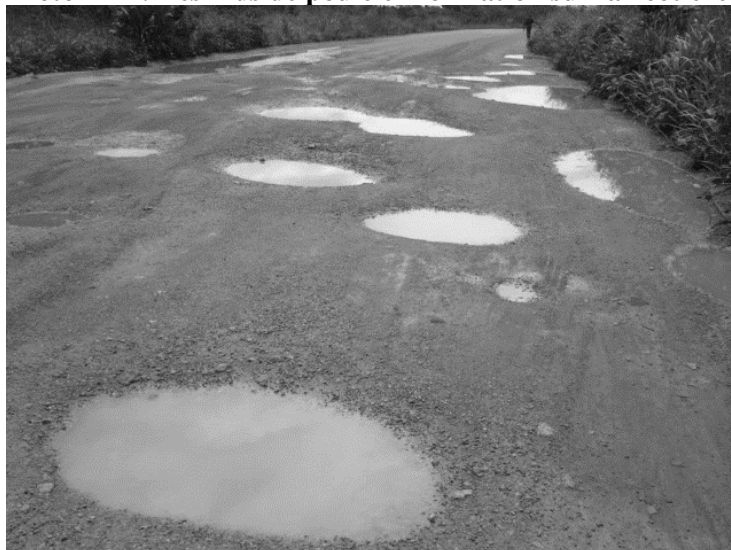
Photo n° 2 : Les nids de poule en formation sur la «côtière»
